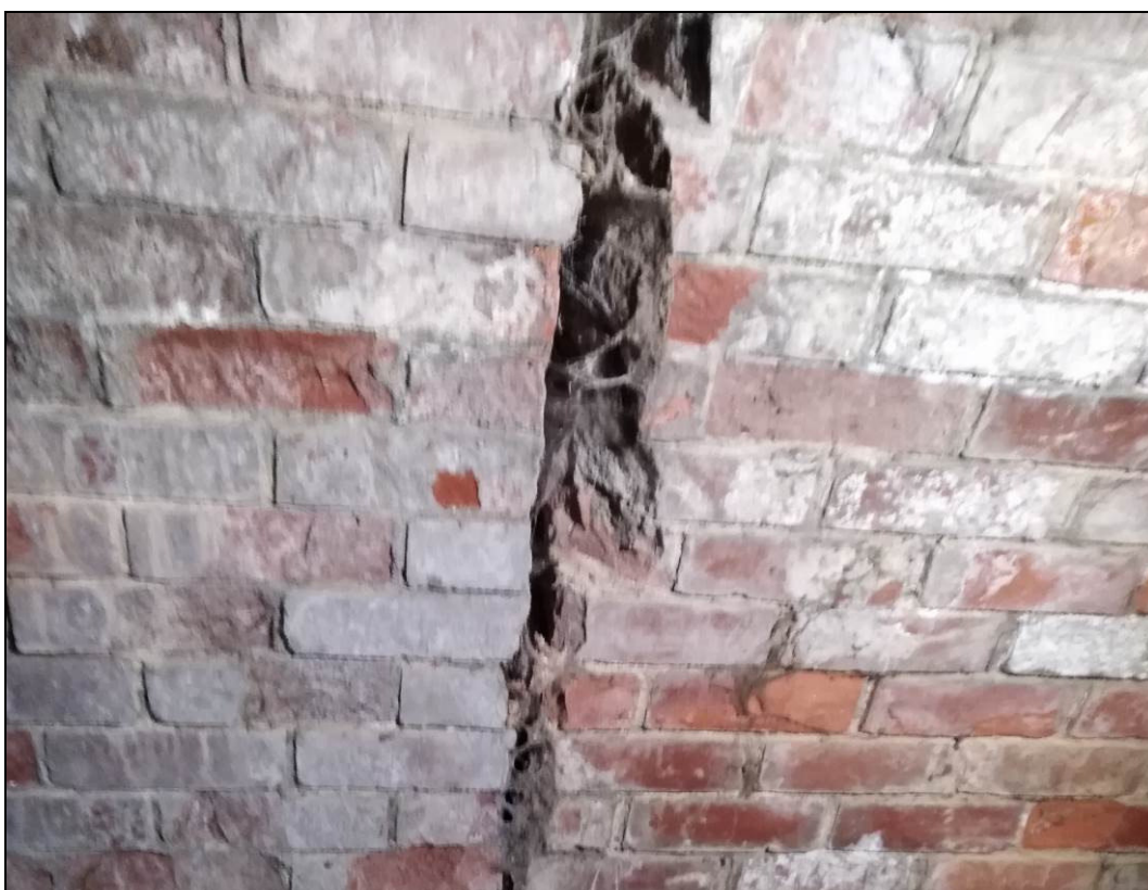
Obr. č. 12 - pohled na trhlinu a vypadávání cihel v cihelném zdivu nosné konstrukce
