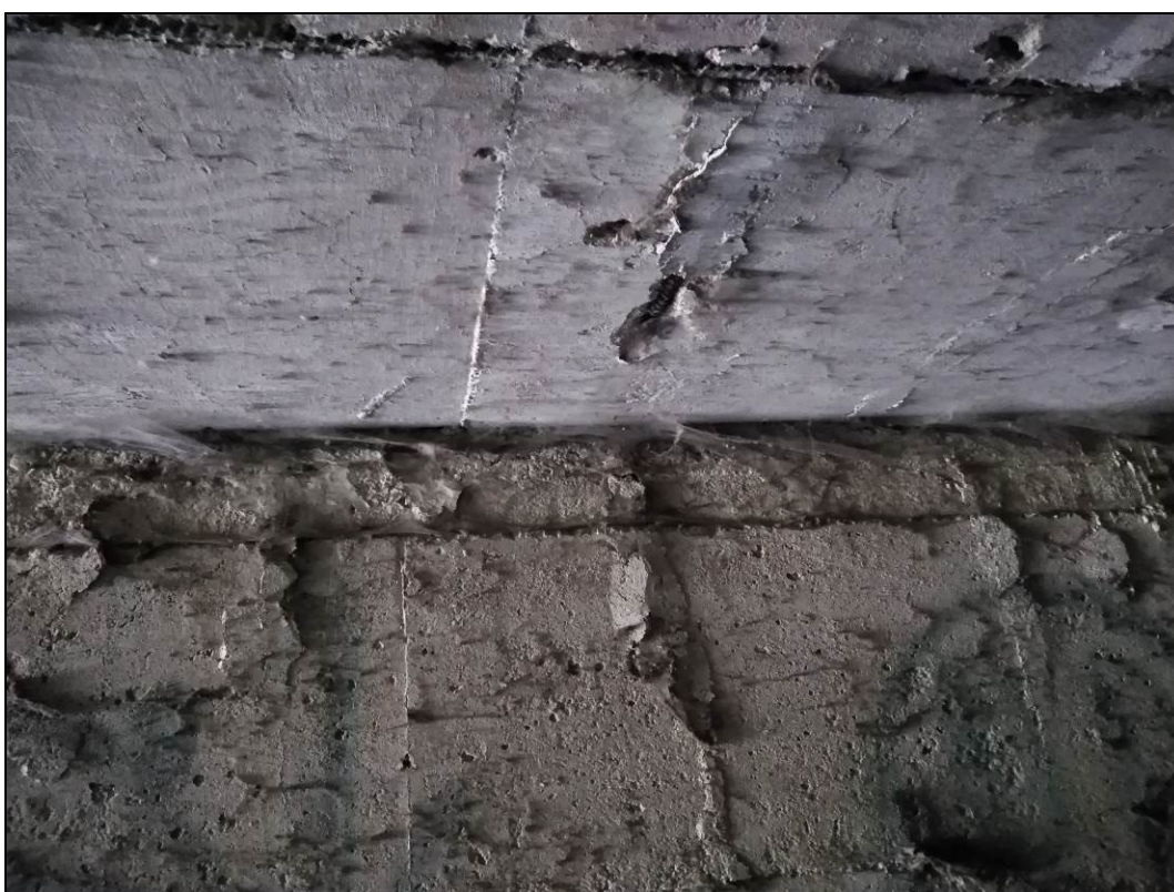
Obr. č. 10 - pohled na opad betonu a odkrytí výztuže nosné konstrukce
