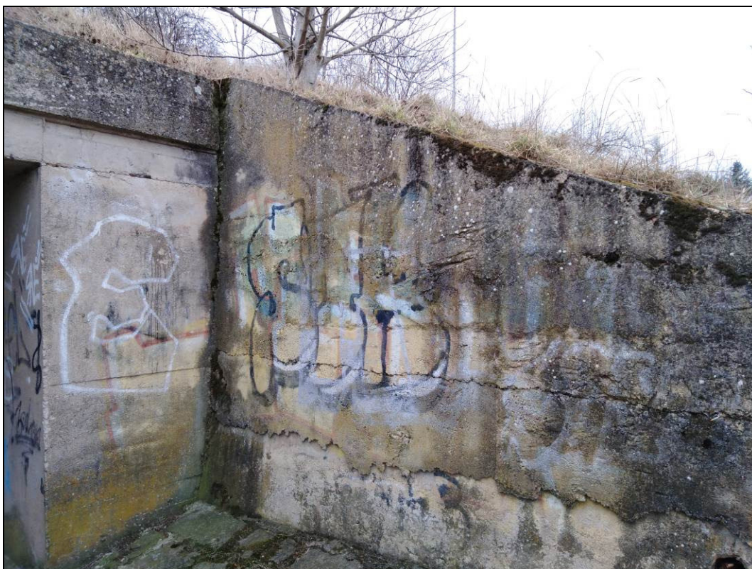
Obr. č. 9 - pohled na zátékání spárou mezi čelem a křídlem
