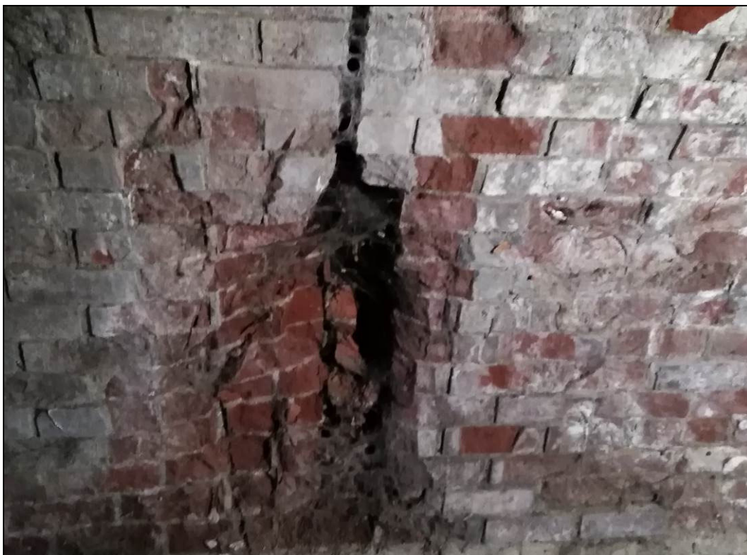
Obr. č. 11 - pohled na trhlinu a vypadávání cihel v cihelném zdivu nosné konstrukce
